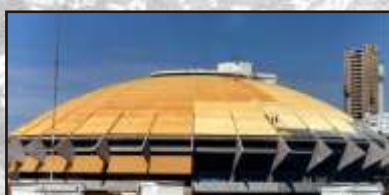
Isolamento térmico de telhas metálicas
