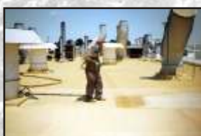
Isolamento térmico de cobertura
