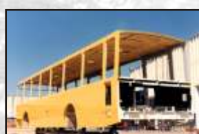
Spray de poliuretano sob teto
