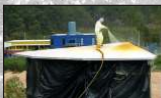
Spray de poliuretano sobre aglomerado de madeira
