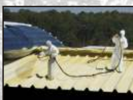
Spray de poliuretano sobre telhas pré-pintadas
