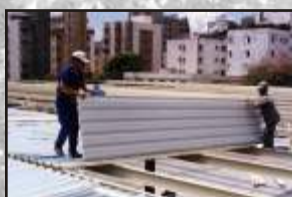
Telha térmica estruturada com poliuretano
