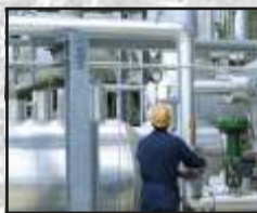
Isolamento térmico em instalações frigoríficas
