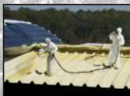
Spray de poliuretano sobre telhas pré-pintadas
