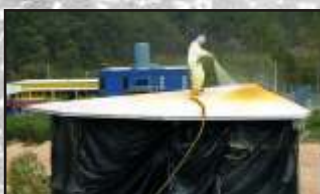
Spray de poluretano sobre aglomerado de madeira
