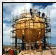
Isolamento térmico em pólo petroquímico
