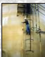
Tanques de óleo
