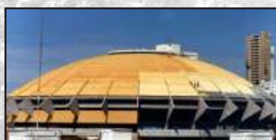
Isolamento térmico de telhas metálicas
