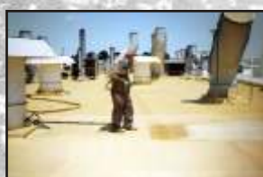
Isolamento térmico de cobertura
