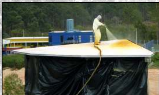
Spray de poliuretano sobre aglomerado de madeira
