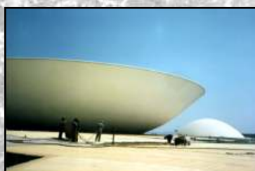
Spray de poliuretano em lajes de corbetura
