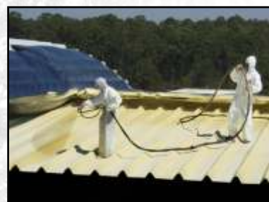
Spray de poliuretano sobre telhas pré-pintadas
